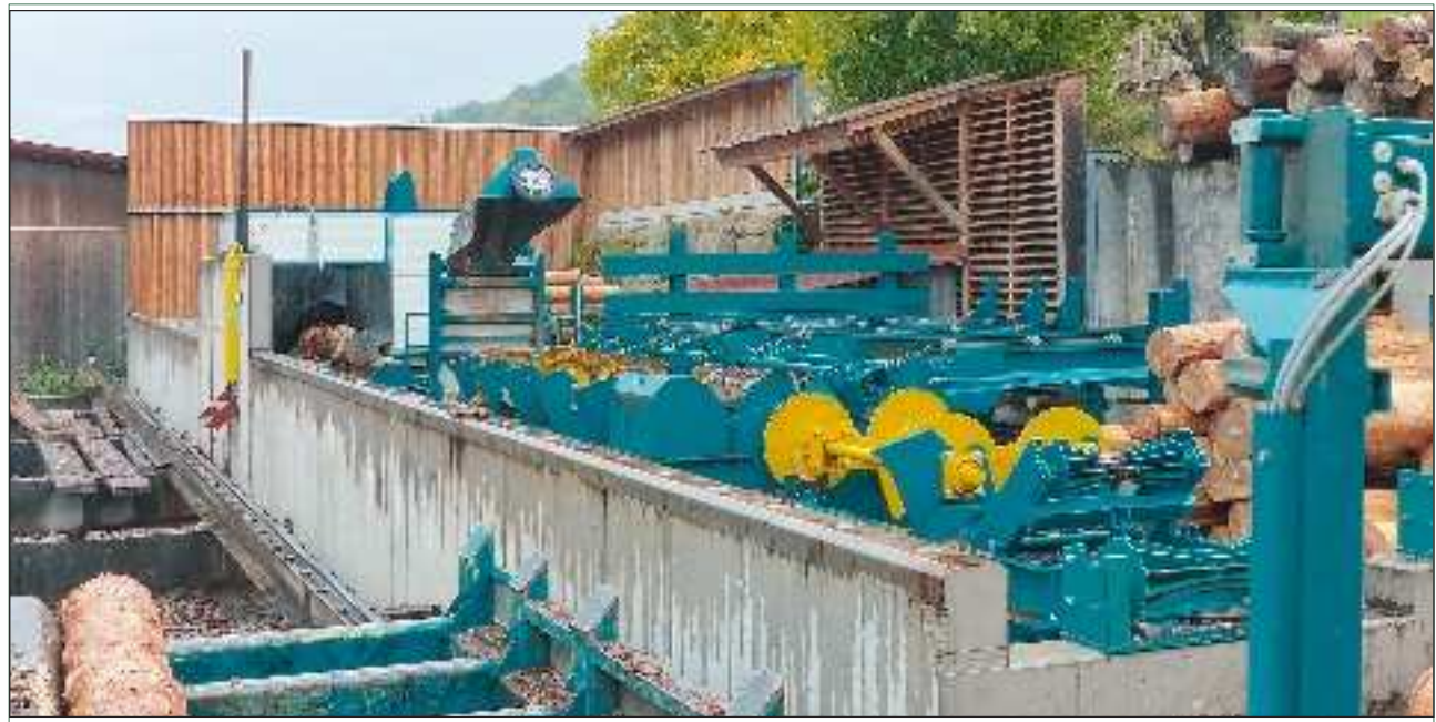
Die automatisierte Entrindungsanlage ist zum Betriebsgelände hin mit einer umlaufenden Betonmauer vollständig abgeschlossen. Mit umfassenden Maßnahmen hat man im Sägewerk Meßmer eine spürbare Reduzierung der Schallemissionen aus der Entrindungsanlage erreicht: Im Hintergrund hölzerne Schallschutzwände, davor die eingehauste Fräskopfstation mit der in diesem Bereich erhöhte Betonmauer und die hier angehebenene Haube über dem Wurzelreduzierer. Fotos: J. Härer
